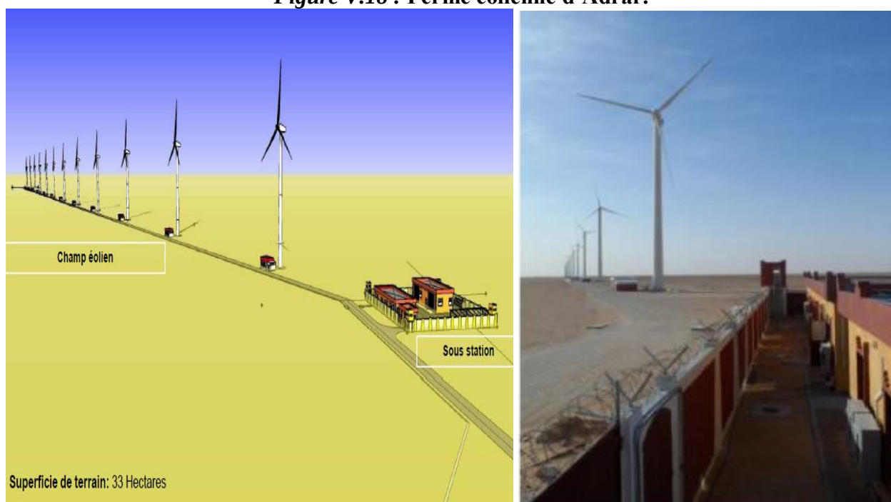
Figure V.18 : Ferme éolienne d'Adrar.
