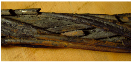
Fig. 12. Ruptures multiples par CSC sur un câble multi-couche.
